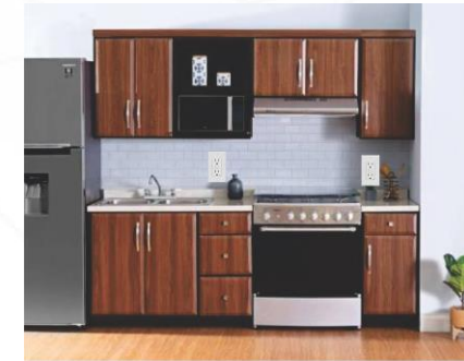
210-52 (a)(4) Los contactos sobre la cubierta no se consideran a los exigidos en 210-52 (a)
